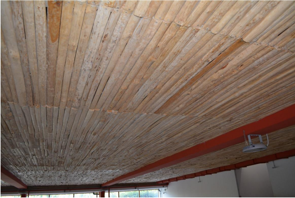
Figura 3: Particolare del tetto all'interno della palestra
